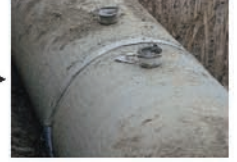
第五步：接头封浆处理
