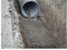
第一步：基础填沙处理
